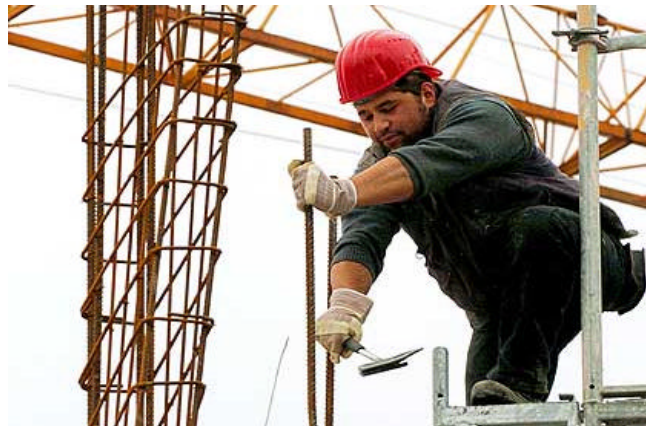
Baustelle Mindestlohn: Wir bleiben dran
